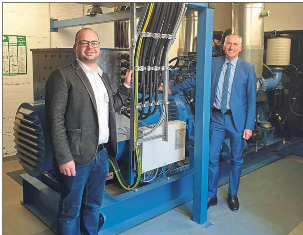
Ein 1000 PS starker Schiffsdiesel springt im Josephs-Hospital im Fall eines Blackouts ein, wie Johannes Klotz (l.) und Peter Goerdeler erklären. Fotos: Fenneker
