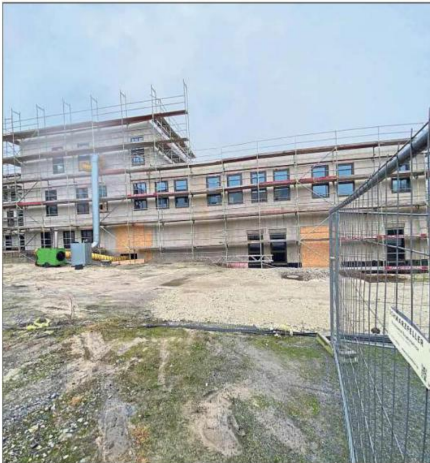
Hinter dem Krankenhaus entsteht derzeit ein zweites Gesundheitshaus. Die Arbeiten liegen im Zeitplan. Foto: Ackfeld
